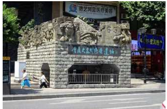
写真＝「六・五大隧道惨案遺址」
